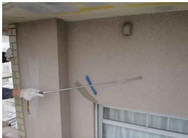
吹付面打診調査
