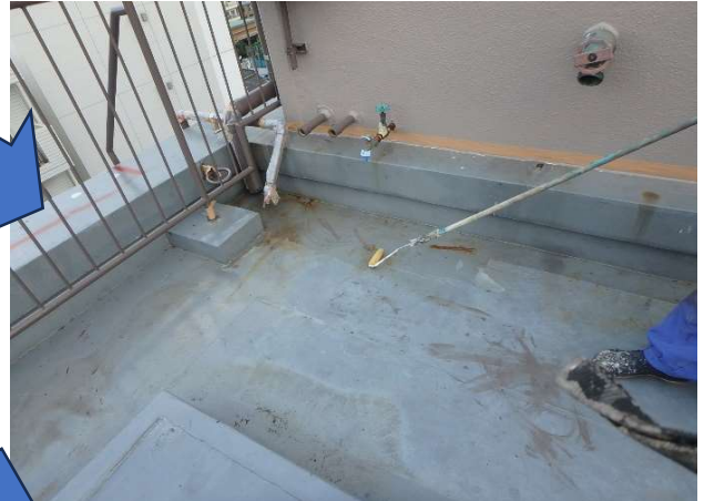
プライマー塗布
