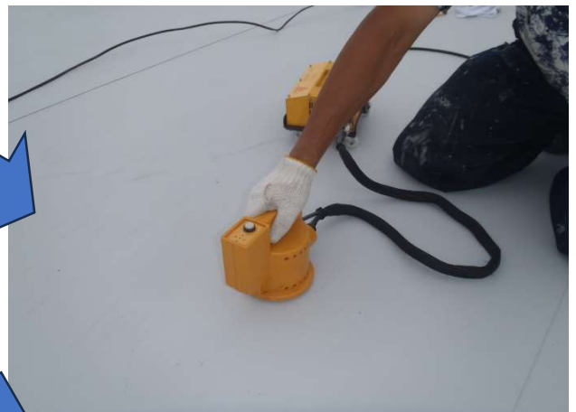
加熱装置による溶接接合
