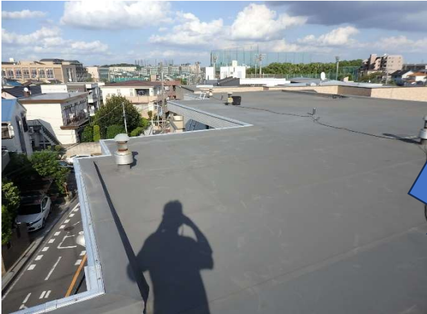
既存塩ビシート防水
