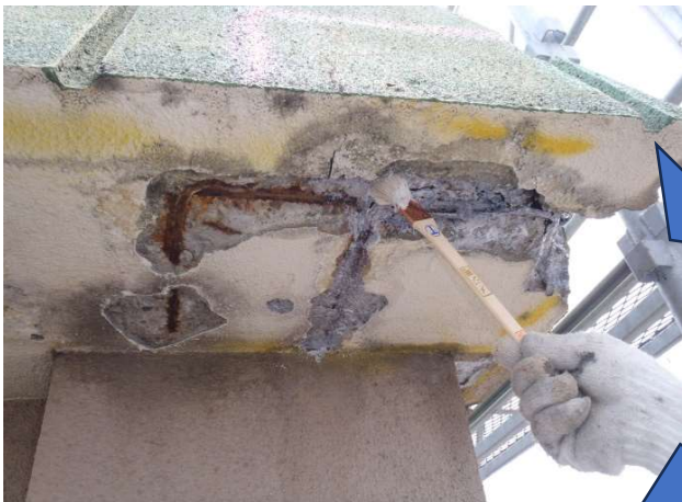
防錆プライマー塗布
