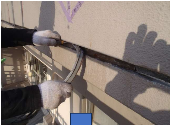
吹付面外壁 ウレタンシーリング仕様
