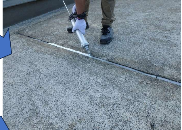
目地撤去・シーリング打ち
