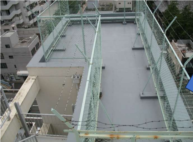
既存ウレタン塗膜防水
