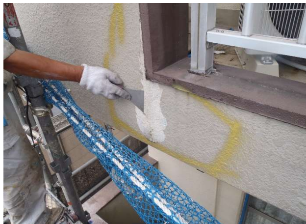
脆弱塗膜補修
