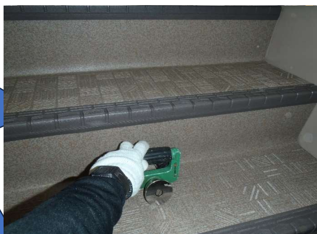
新規長尺シート貼り
