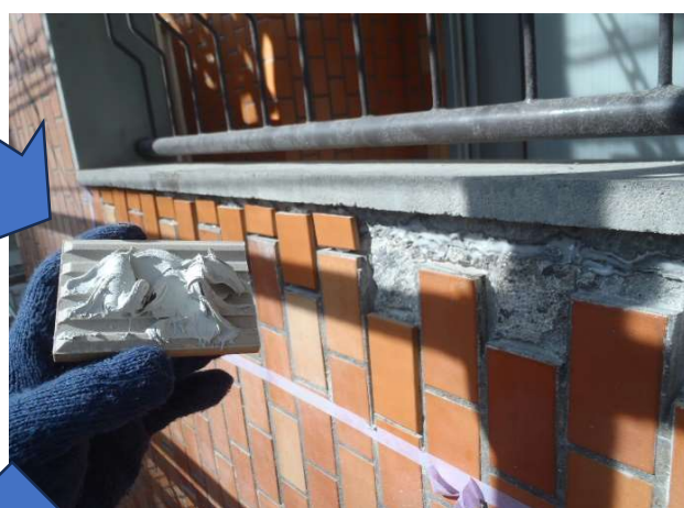
新規タイル貼り
