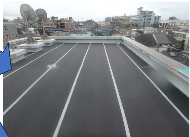
通気緩衝シート貼り
