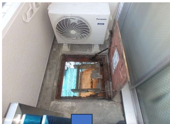
避難ハッチ交換工事
