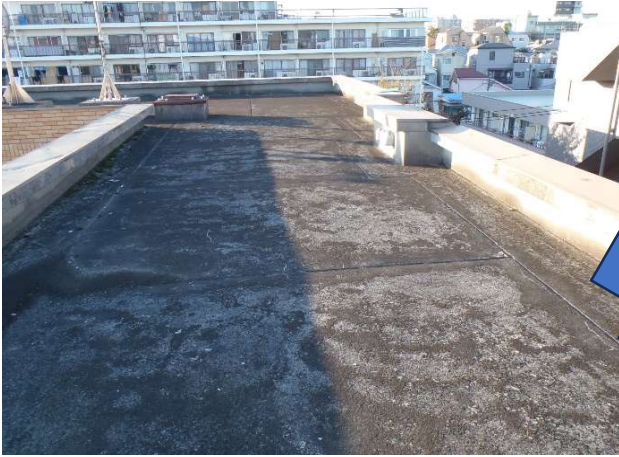
既存アスファルト防水
