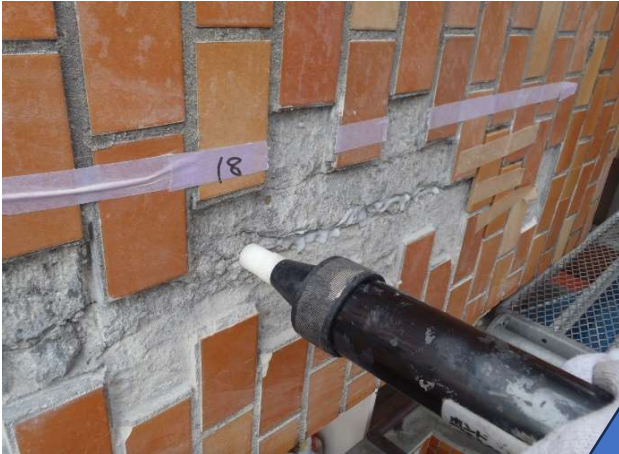
弾性エポキシ樹脂注入
