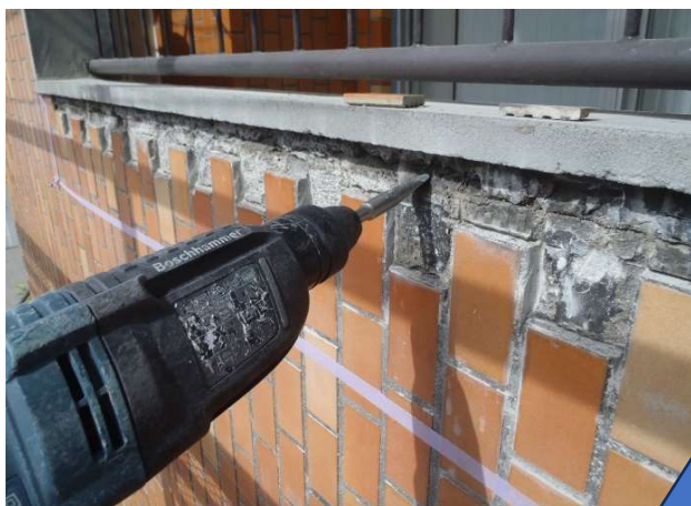
既存タイルの撤去
