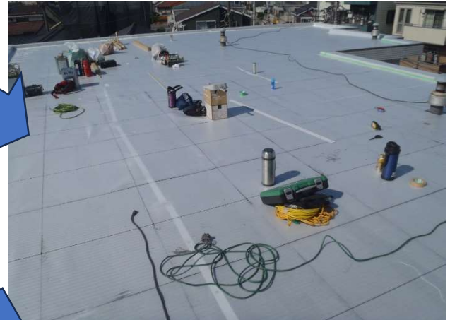
緩衝シート下張り
