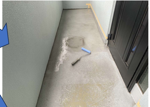
プライマー塗布
