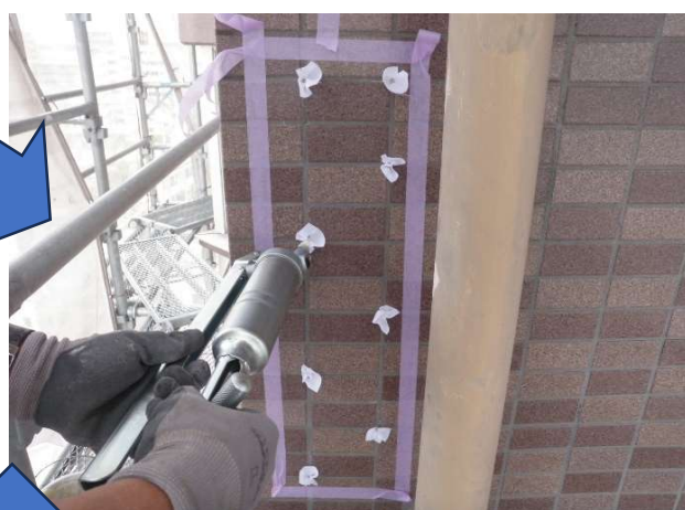
エポキシ樹脂注入
