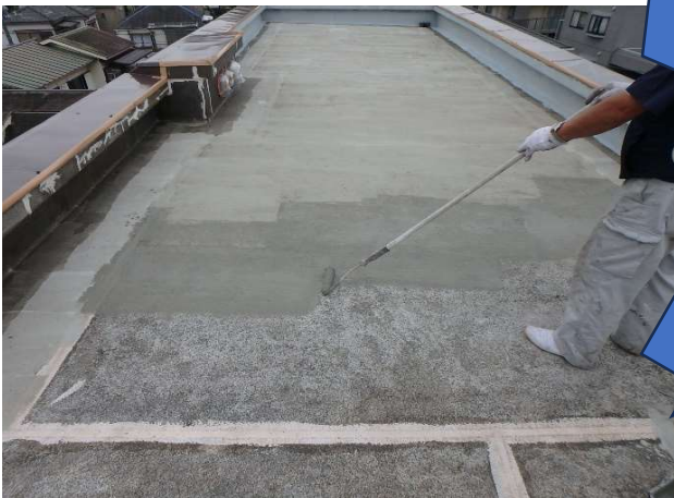
仮防水材塗布
