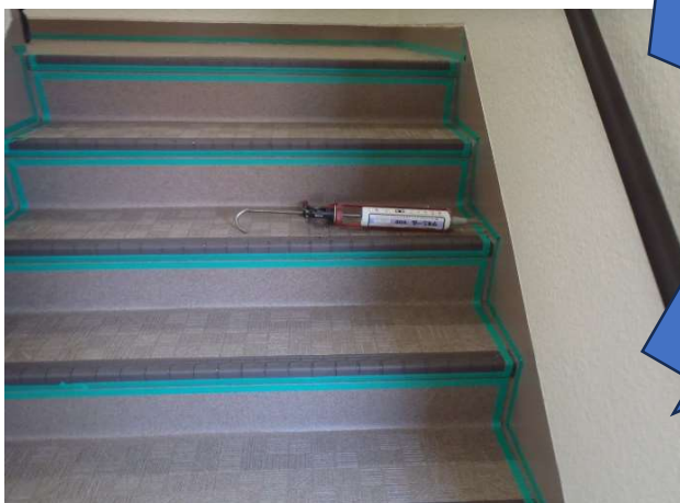
入隅シーリング打設
